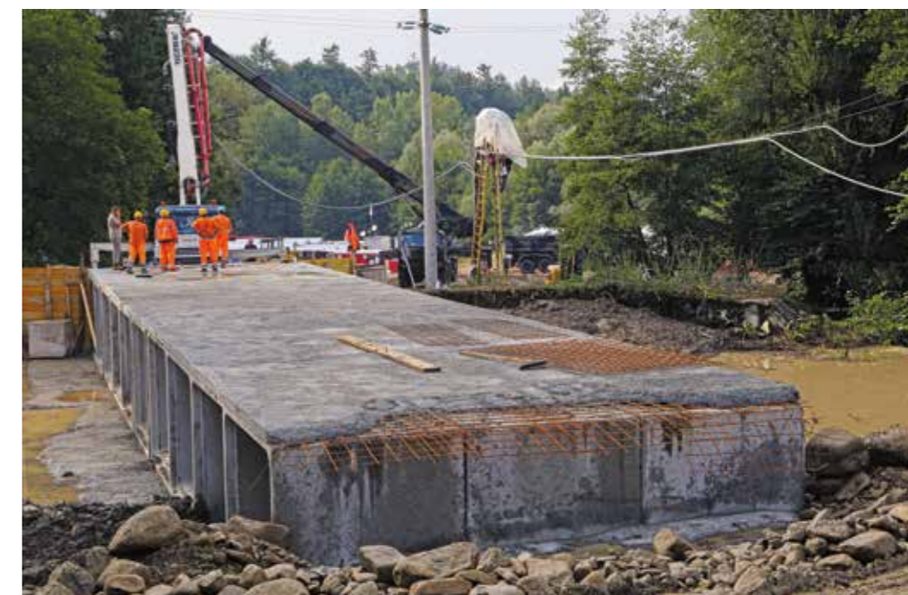
Foto 97. Amatrice, 2016. Interventi di ripristino del ponte "Tre Occhi" danneggiato dal terremoto.
