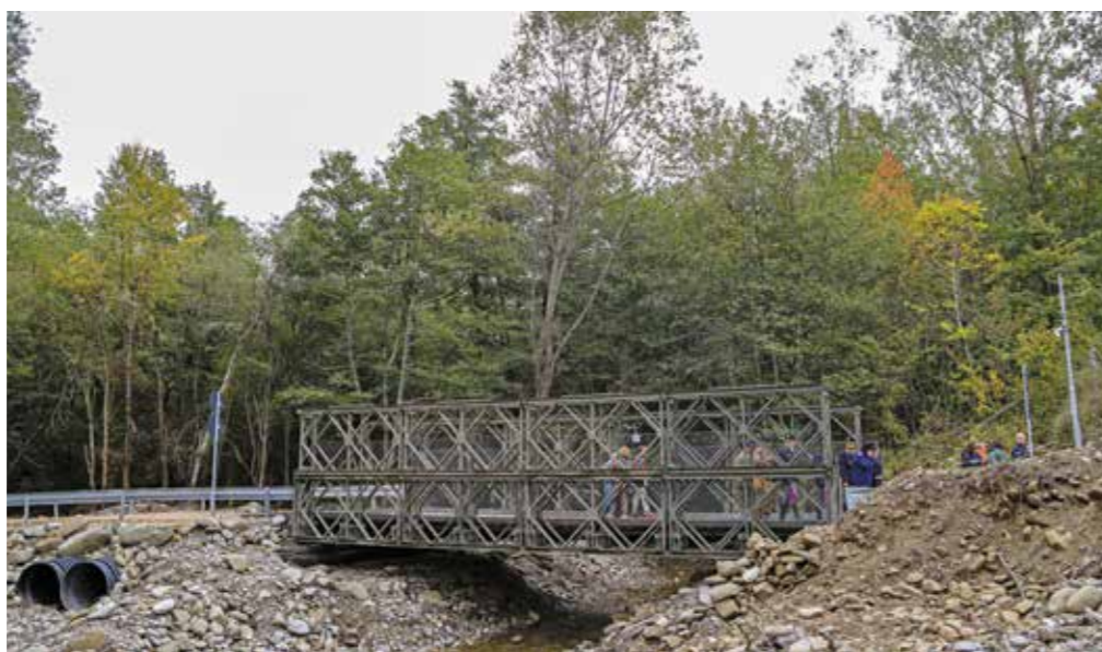
Foto 98, 99. Amatrice, 2016. Installazione di un ponte bailey in località Retrosi per il ripristino della viabilità stradale.
