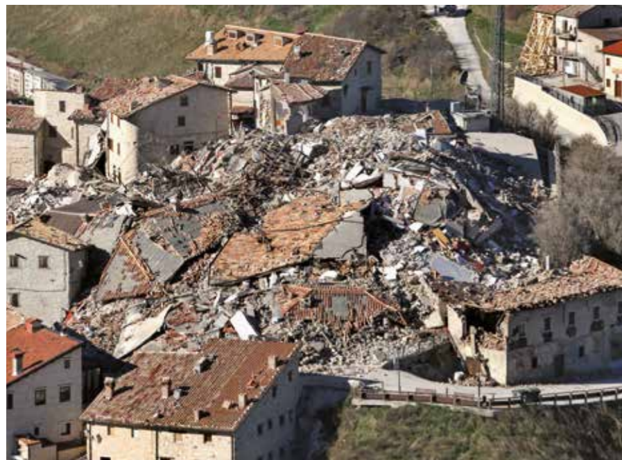
Foto 1. Castelluccio di Norcia, Perugia, 2016. I crolli causati dal terremoto del 30 ottobre.
