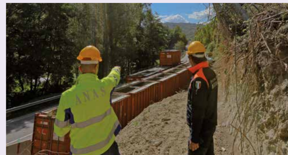
Foto 49. Pescara del Tronto, Ascoli Piceno, 2016. Intervento di ripristino della viabilità dopo i dissesti idrogeologici causati dal terremoto.
