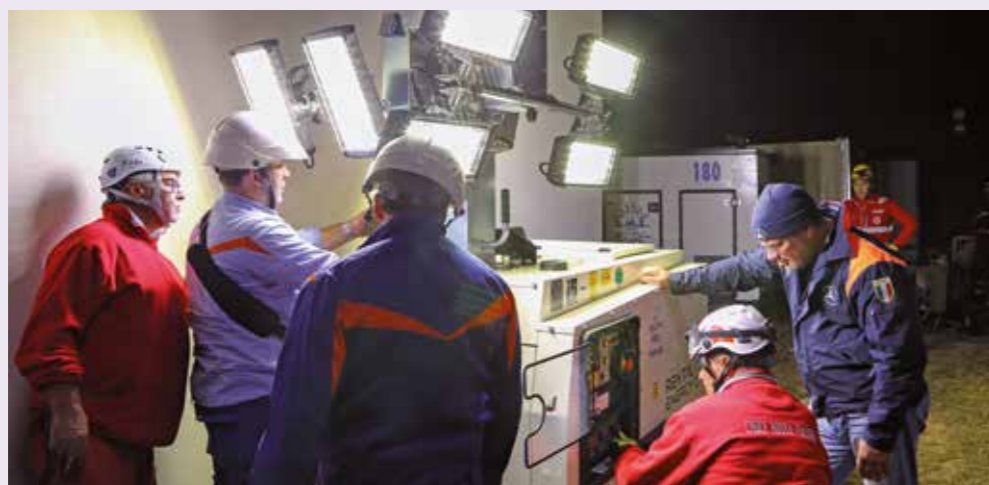
Foto 48. Rieti, Lazio, 2016. Tecnici Enel, volontari di protezione civile e funzionari del Dipartimento della Protezione Civile impegnati nel ripristino dell'energia elettrica in seguito al terremoto.
