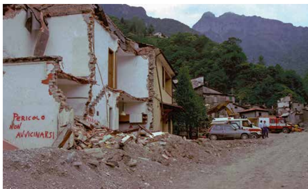
Foto 37. Le abitazioni distrutte dall'alluvione in Versilia del 1996.
