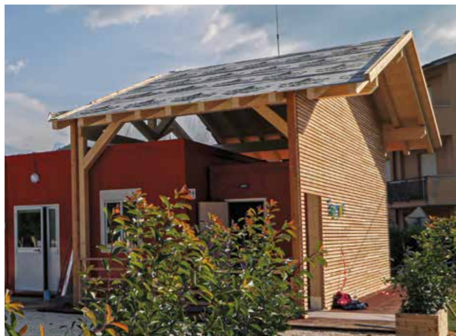
Foto 115. Amatrice, 2016. MUSP-Moduli a Uso Scolastico Provvisori realizzati dopo il terremoto nella frazione di San Cipriano dalla Protezione Civile della Provincia Autonoma di Trento.
