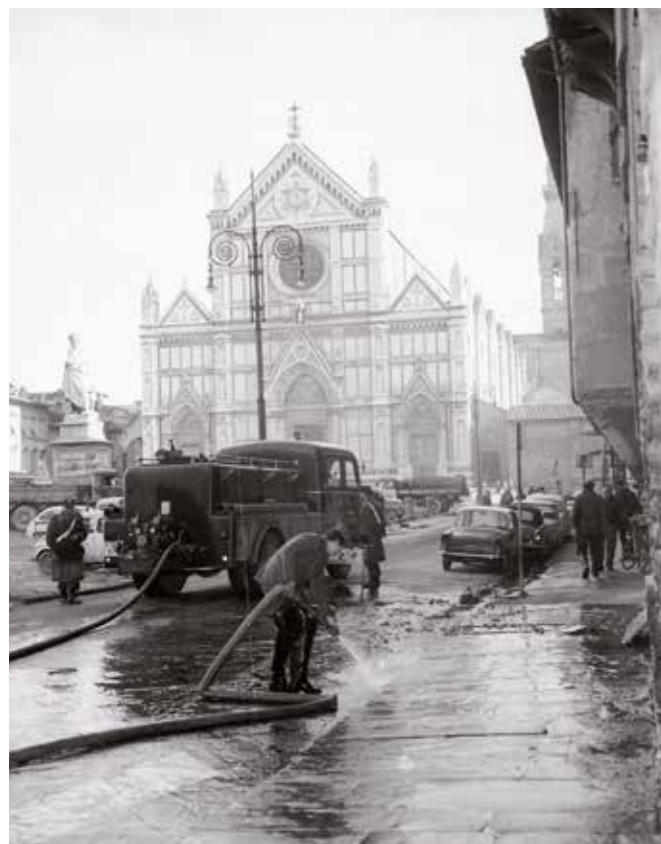
Foto 25. L'alluvione di Firenze del 4 novembre 1966.
