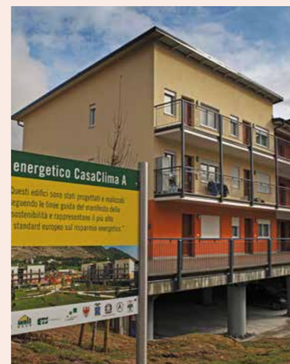
Foto 92. L'Aquila, 2009. Edificio realizzato nell'ambito del Progetto CASE-Complessi Antisismici Sostenibili Ecocompatibili.
