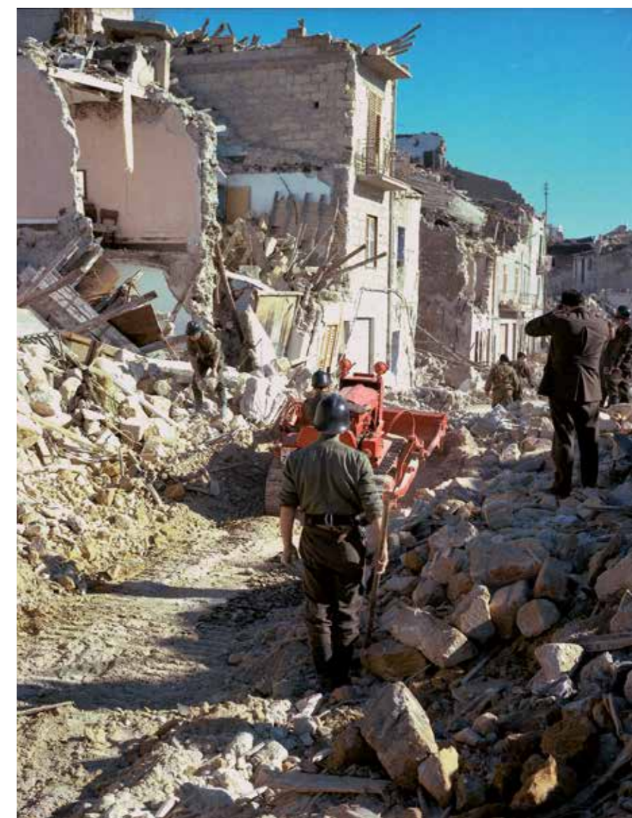
Foto 26. I danni causati dal terremoto che nella notte tra il 14 e il 15 gennaio del 1968 colpì la Valle del Belice nella Sicilia occidentale.
